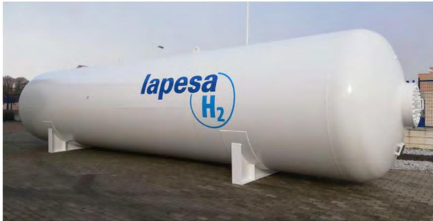
*Ilustración 12. Tanque de almacenamiento 200 m<sup>3</sup> de H<sub>2</sub>.*
