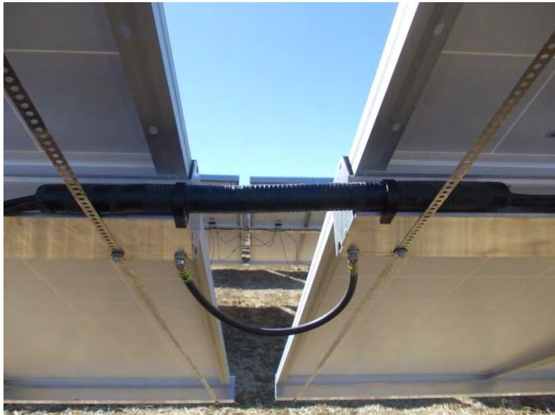
Unión de la estructura mediante cable de cobre 35 mm<sup>2</sup>
