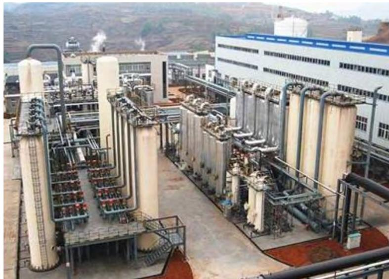
*Ilustración 20. Planta de producción de hidrógeno por reformado con vapor.*
